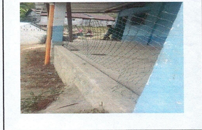
CERCO O MURO PERIMETRAL
